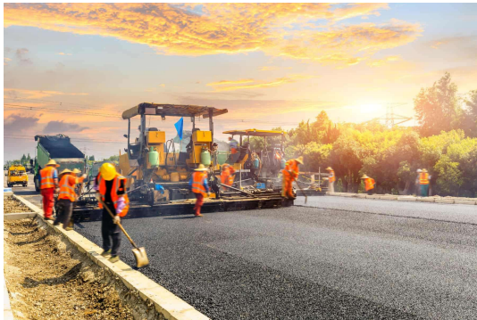
Şekil 3. Asfalt yol kaplaması inşaatı
